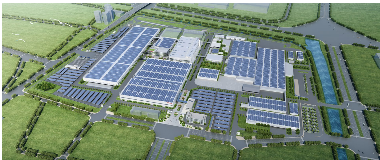
全新电动车工厂（建设中）
